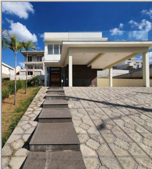
Sobrado no Condomínio Res. Portal Horizonte
