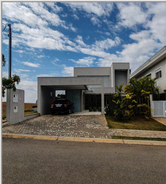
Sobrado no Condomínio Vale das Águas
