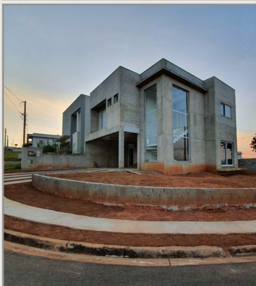
Sobrado de Esquina no Condomínio Vila Real
